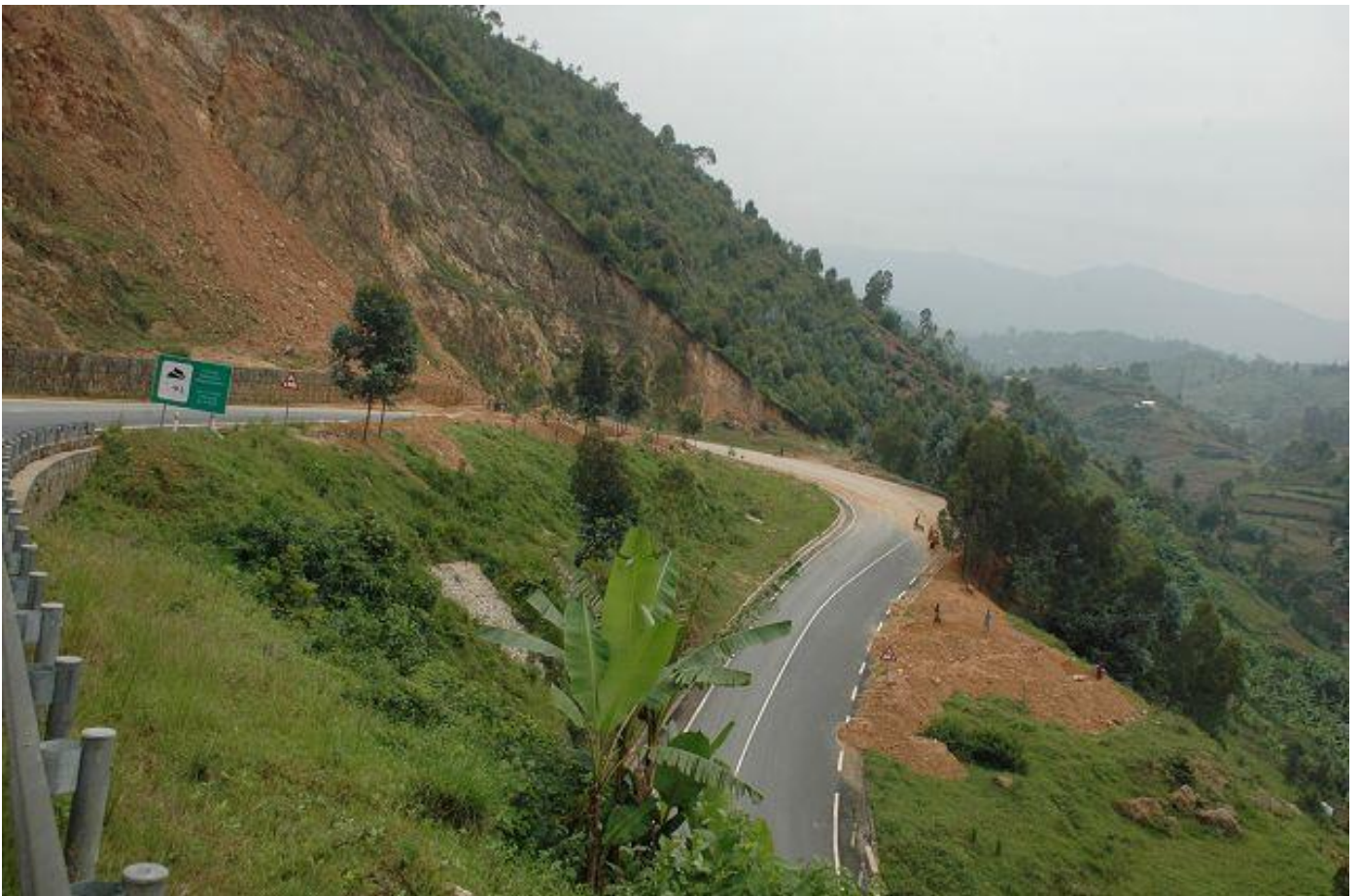
Eine Gerölllawine hat die Strasse verschüttet
